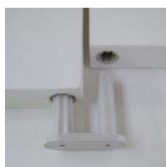
La partie lisse vient se positionner dans l'insert du 2 ème panneau
